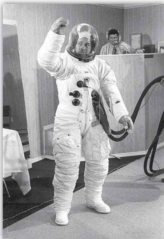
Lo strato esterno, mostrato in Figura 8.17-6, è realizzato in materiali ignifughi e resistenti all'abrasione e serve come protezione termica e per riparare l'astronauta dai *micrometeoroidi*, particelle microscopiche di polvere che viaggiano nello spazio ad altissima velocità e colpiscono gli astronauti sulla superficie lunare come finissimi proiettili, che vengono fermati dagli strati multipli della tuta esterna.
