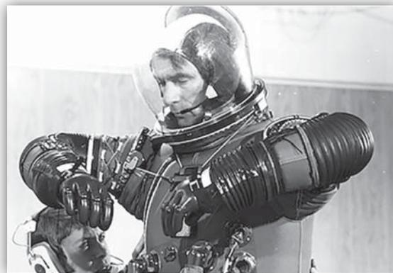
*Figura 8.17-2. Gene Cernan verifica la taglia dello strato ermetico della tuta spaziale, il Pressure Garment. Si notano le articolazioni a soffietto anche sulle dita.
